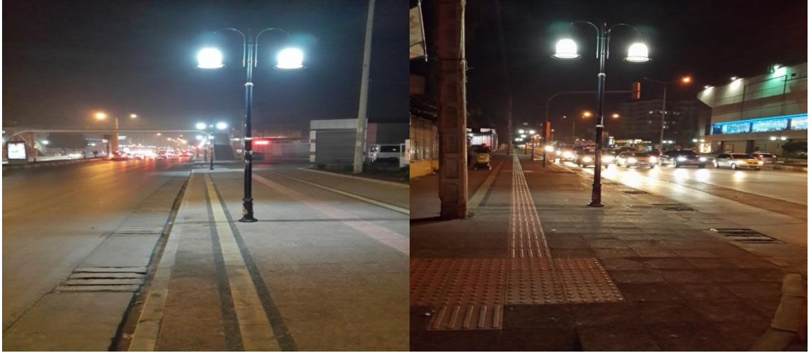
GMK Bulvarı'ndaki aydınlatma direklerinin bakım onarımı yapıldı
