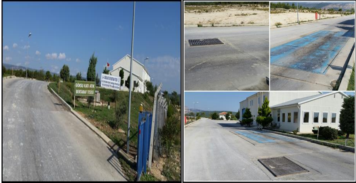
Silifke Göksu Katı atık Düzenli Depolama ve Bertaraf Tesisine ait görüntüler
