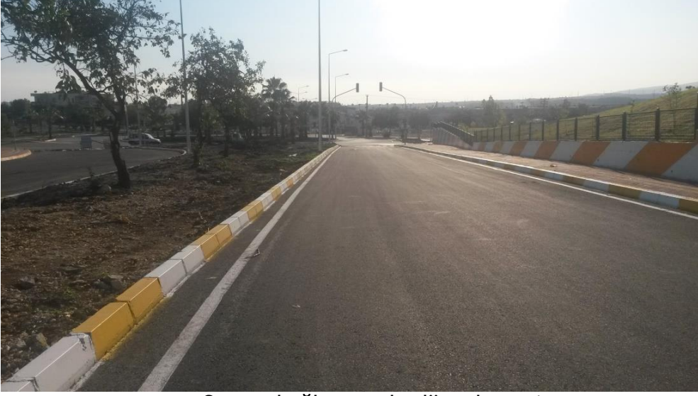
Otogar bağlantı yolu düzenlemesi
